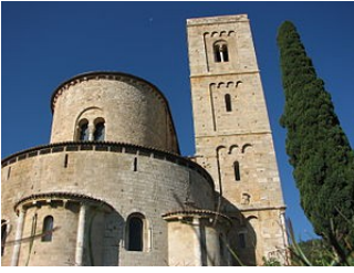
L'abside et le campanile de l'église
